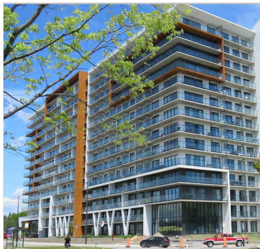
Édifice Le Sommet, 935, avenue Roland-Beaudin.
