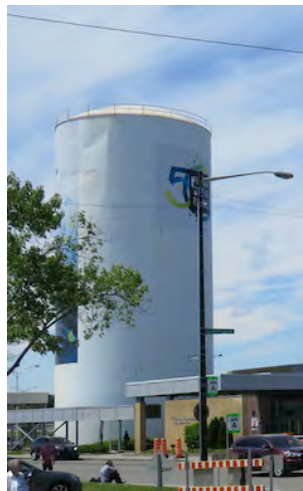
Le château d'eau de Sainte-Foy.
