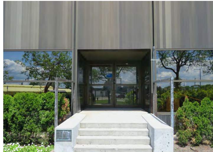
Détail du revêtement d'aluminium refoulé anodisé et des cadres métalliques de fenêtres. Entrée sud.
